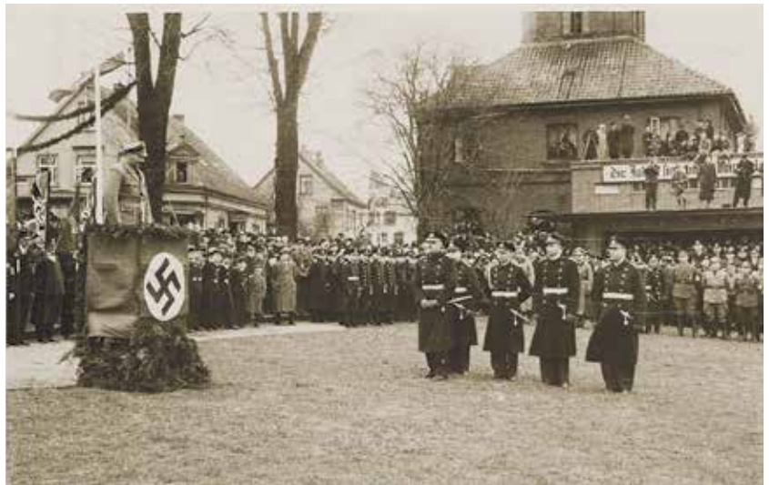
Mit großem militärischem Aufwand wurde am 1. April 1937 der Einzug der Marine-Garnison in die neuen Braker-Marine-Kasernen gefeiert und fand seinen Schluss- und Höhepunkt in einer Kundgebung an der Braker Kaje. Am Rednerpult Brakes NS-Bürgermeister Karl Reich, in der Gruppe der Marine-Offiziere vorne links der erste Kommandeur Korvetten-Kapitän Max Glaser. An der Wartehalle vor dem Telegraphen prangt der antisemitische Hetzspruch „Die Juden sind unser Unglück“. _Foto: Archiv Kirsch
