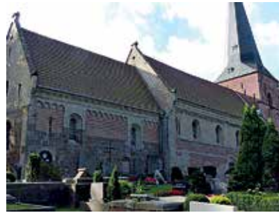
Kirche St. Hippolyt in Blexen, Nordseite von Chor und Schiff mit Turm. Foto: Ulamm, Wikimedia, CC BY-SA 4.0
