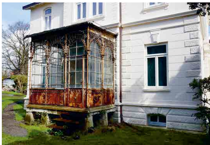
Eine Stahl-Glas-Konstruktion: der Wintergarten der Unter- nehmervilla.
