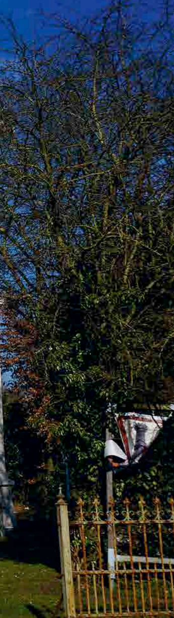
Oben links: Die denkmalgeschützte Familienvilla wurde 1899 von Rudolf Winicker erbaut.
