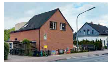
Abbruchhaus in der Arbeitersiedlung Sansibar in Drielake. _Foto: Jörgen Welp
