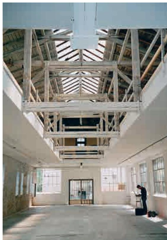
Oben: Die Innenperspektive der Halle mit den hölzernen Sprengwerken, die zur Stabilisierung dienen und gleichzeitig für eine gute Belichtung sorgen. Oben links: Die Außenansicht der heutigen Bauwerkhalle.
